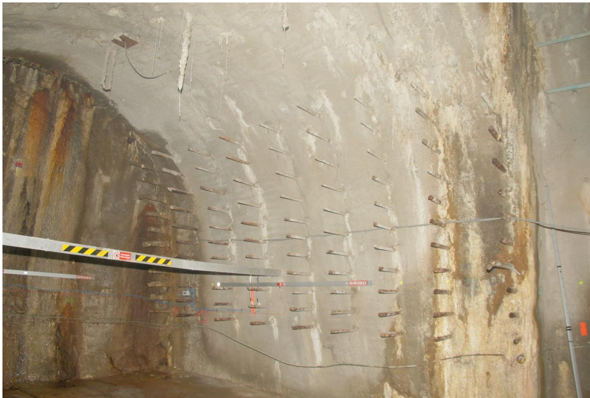
Napojení náraziště primárního kolektoru Hybešova-I do TG11 ( pohled z TG11)
